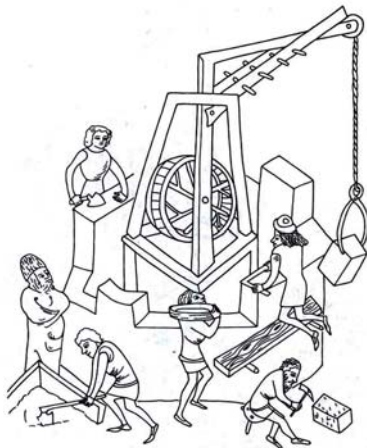
Turmbau mit einem Kran 1365
